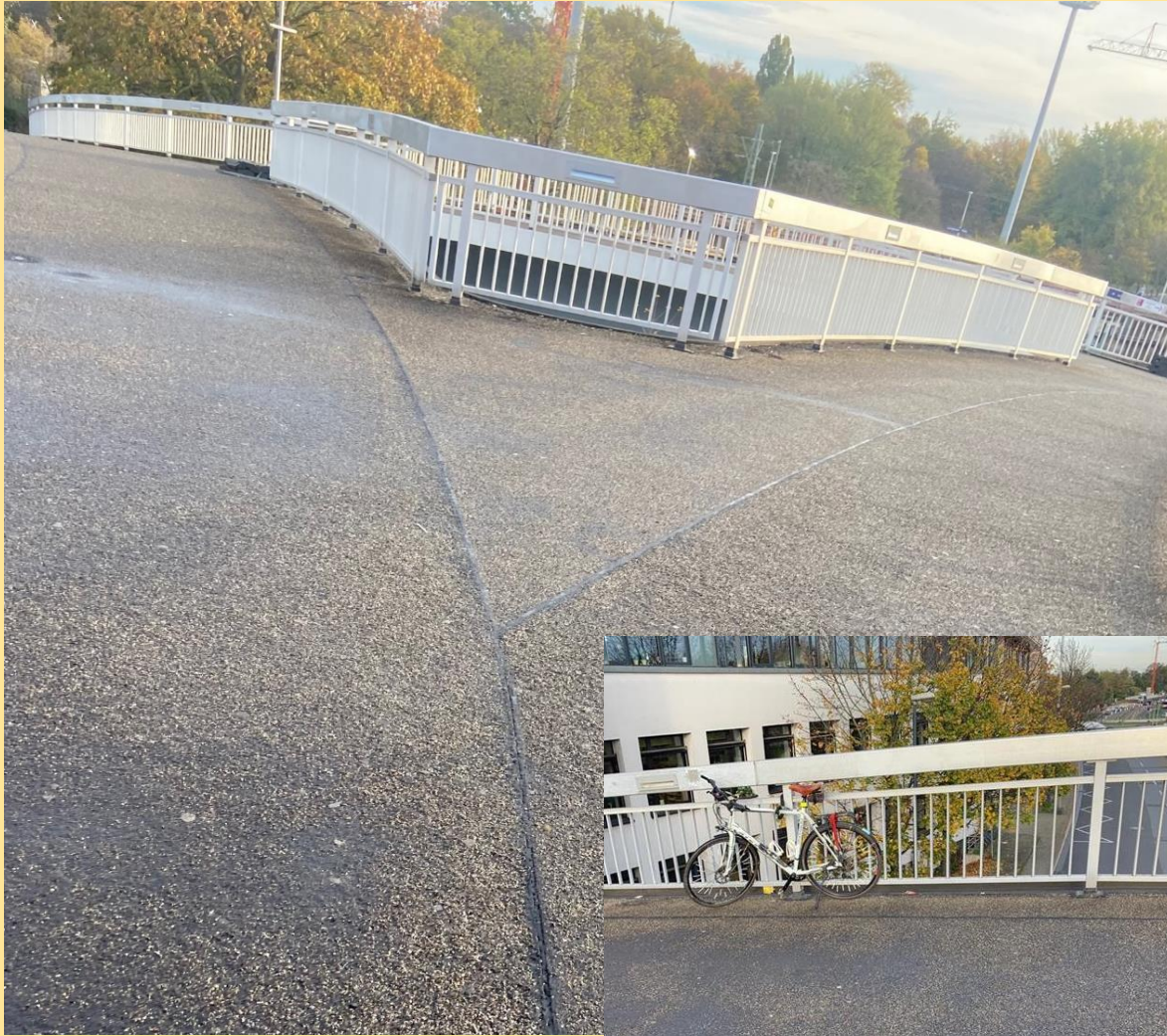
Brücke über den Europaring
